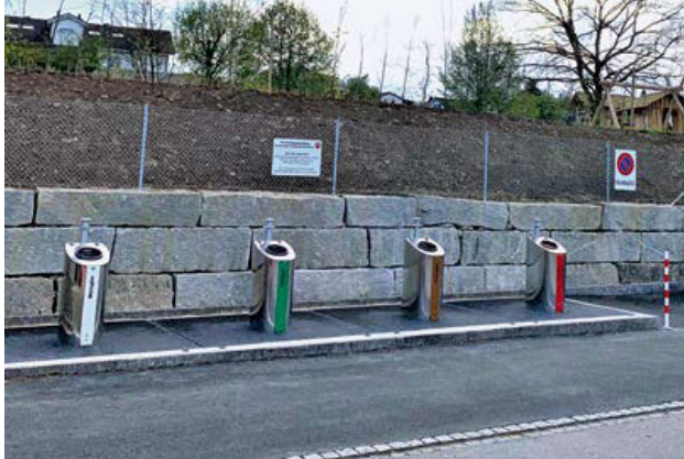
Unterflursammelstelle in Fischbach-Gösglikon, im Jahr 2023 von uns erstellt.
